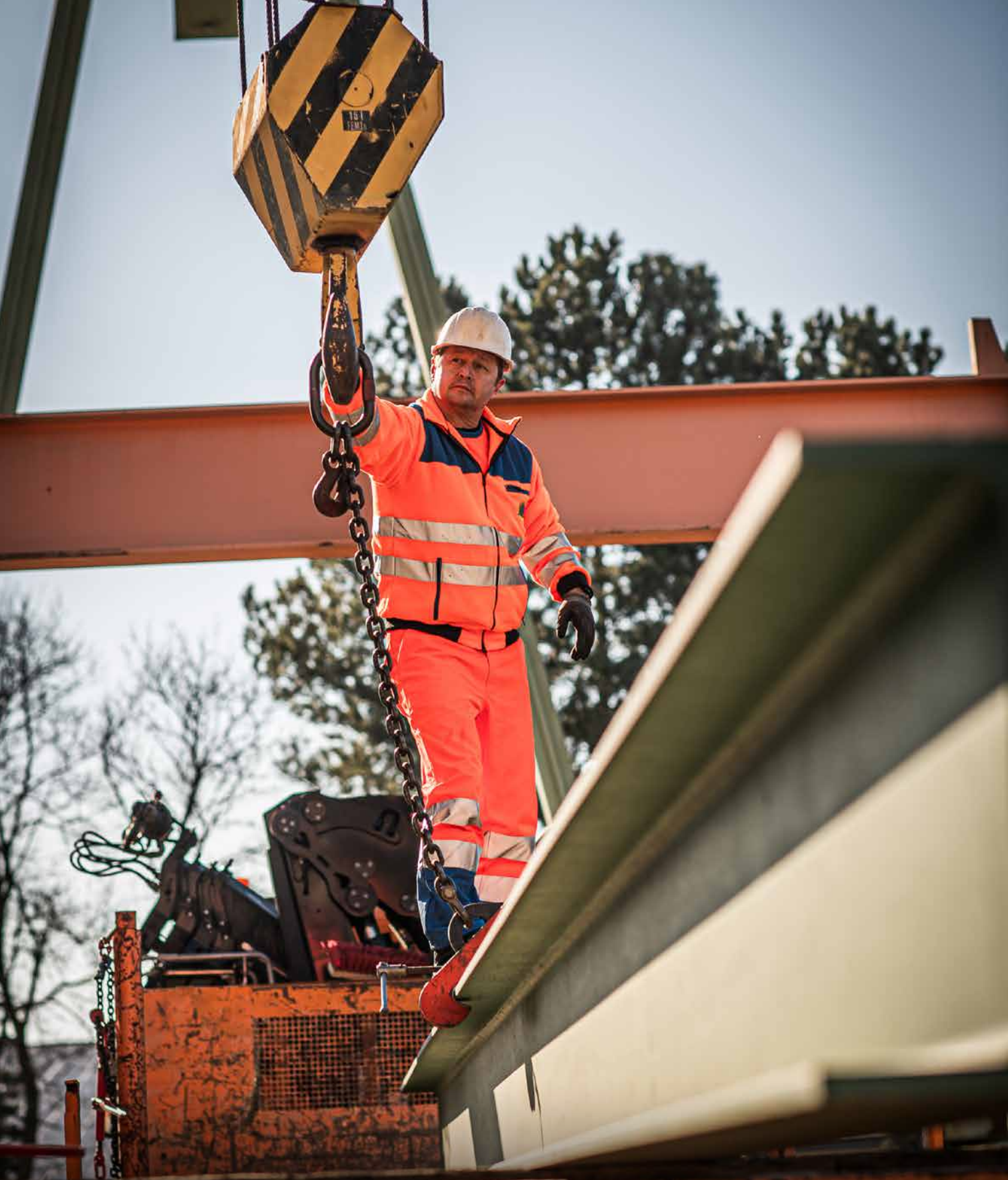
Die Stahlträger werden präzise verladen und machen sich auf den Weg zu einer der ersten Brücken-Baustellen der Saison in Korneuburg.
